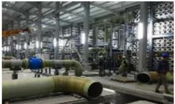
عين وزير الطاقة والمناجم، محمد عرقاب، مشروع إنجاز محطة تحلية مياه البحر ببلدية قورصو (ولاية بومرداس) أين أكد على ضرورة تسريع وتيرة إنجاز هذه المنشأة التي تصل طاقتها الإنتاجية إلى 80 ألف
